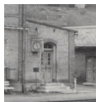
Jöhstadt; Station sidebygning Bahnhof Anbau Station extension
