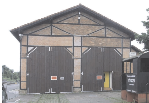
Remise Sinnsheim Lokschuppen Sinnsheim Engine Shed Sinnsheim
